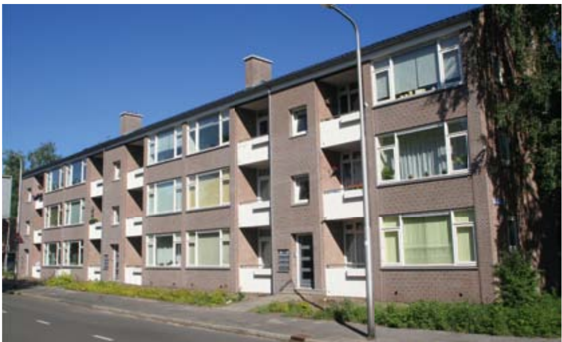
Bosweg na renovatie, Amersfoort
